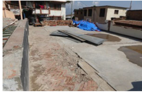
Maison de retraite : emplacement du bâtiment.
